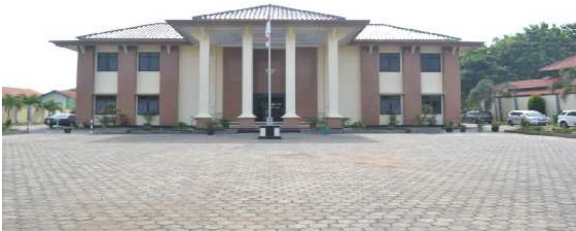
Gambar 1: Gedung Pengadilan Agama Kendal Kelas I-A
