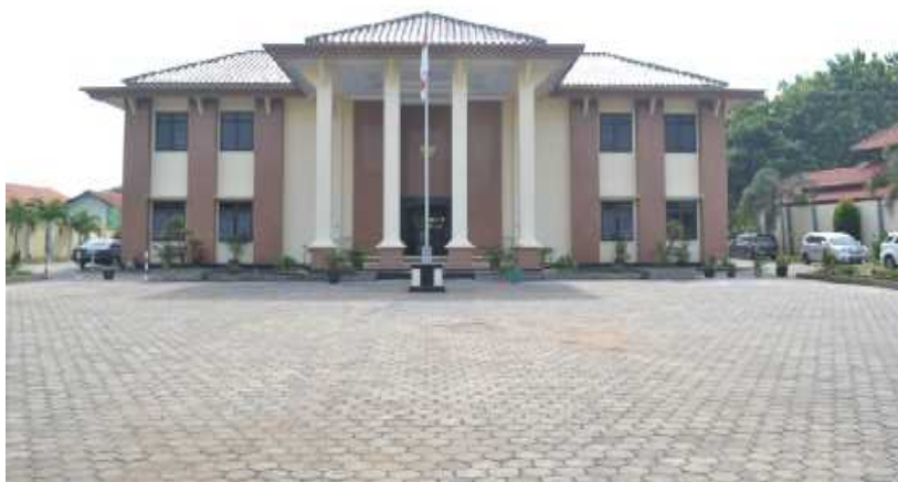
Gambar 3. Gedung Baru Pengadilan Agama Kendal Kelas 1-A 2017 Tampak depan
